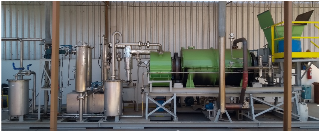
Figura 10 - Vista geral da UTR2
